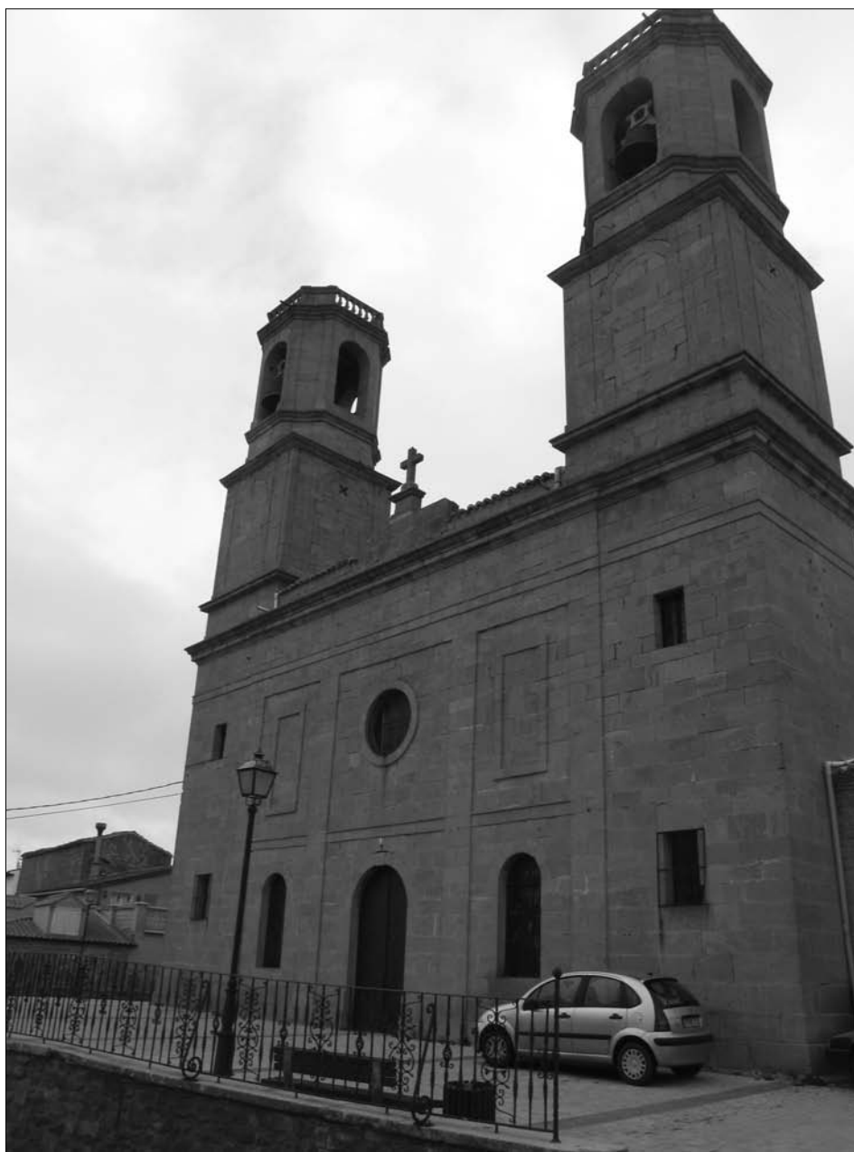
Fig. 7. Fachada de la Iglesia.
