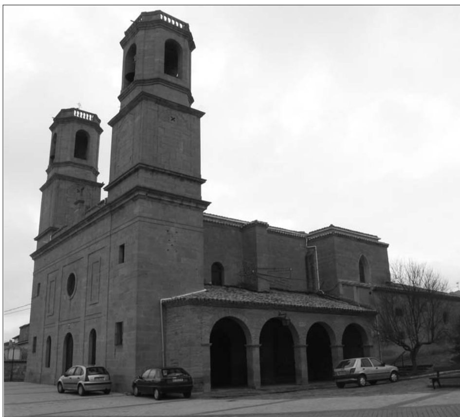
Fig. 6. Vista de la Iglesia.
